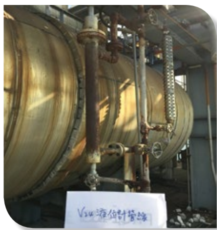
管線除鏽油漆處理
