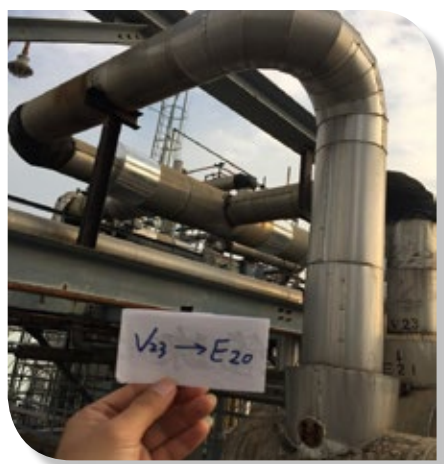
管線保溫破損修補
