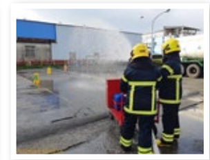
▲ 瀉水洩壓後進行止漏作業
